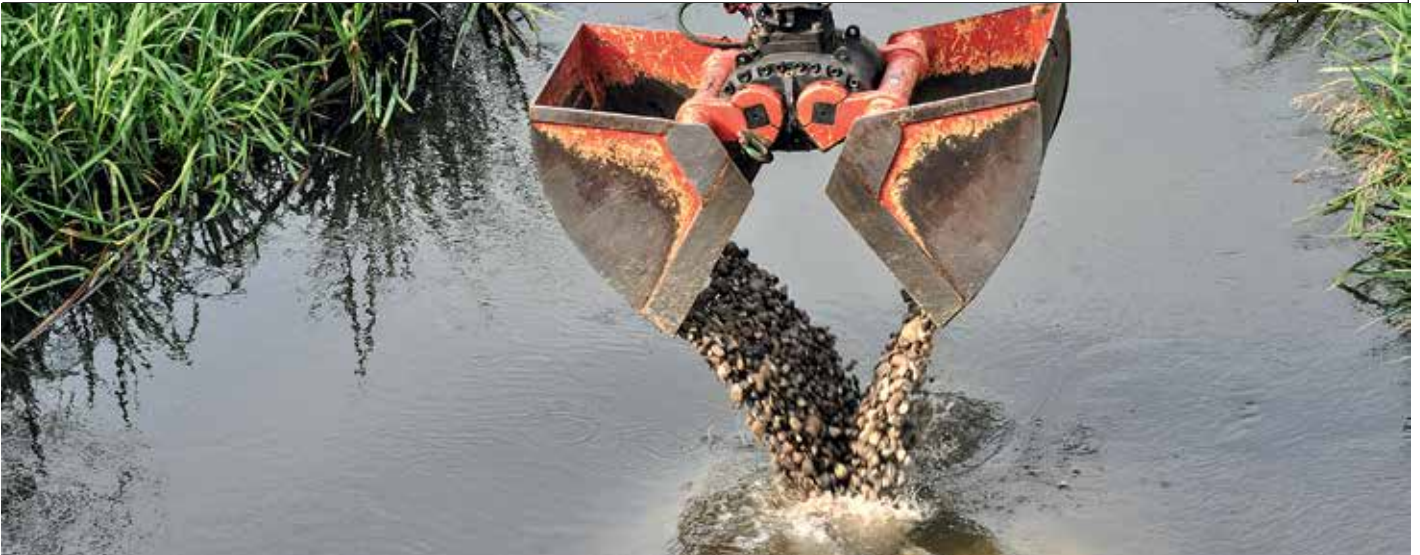
Der Bagger benötigte mehr als zwei Stunden, um die 54 Tonnen Laichkies in die Dosse abzulassen.
